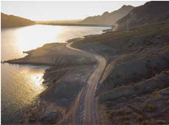
La obra incluyó una bicisenda de 1,6 km de longitud y 3,80 m de ancho pavimentada en concreto asfáltico.
