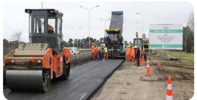
evitar, así, la realización de tres pasadas. Todo esto se llevó a cabo en una cancha de prueba, y bajo estricto control y con el acuerdo del Laboratorio de Pavimentos de la Facultad de Ingeniería de la UNLP. Las muestras testigos resolvieron que la compactación y la calidad estaban en un todo de acuerdo con las especificaciones técnicas del pliego. Lógicamente los tiempos se acortaron en beneficio de una mayor celeridad en la obra.
