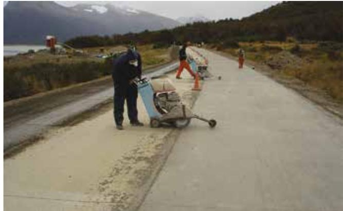
**Figura 7:** Dos aserradoras trabajando simultáneamente a juntas alternadas
