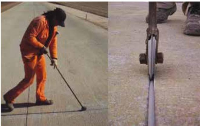
El cordón de sostenimiento o respaldo tendrá un diámetro mínimo un 25 % mayor que el ancho de la junta, y será de material adecuado para la temperatura de colocación del sellador. Su colocación se efectúa con una herramienta especial, que consiste en una rueda con una pestaña de longitud apropiada, que posiciona el cordón a la profundidad necesaria.
