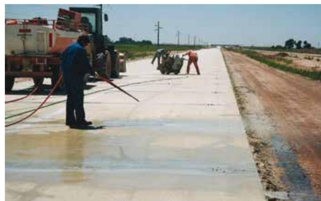
**Figura 9:** Hidrolavado a presión
