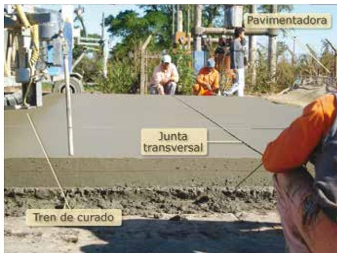
Figura 3: Marcado de junta transversal para el posterior aserrado
