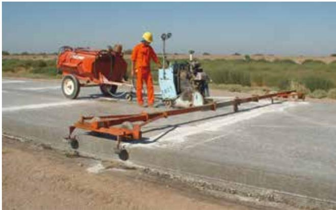
Figura 4: Guía para aserrado de junta longitudinal
