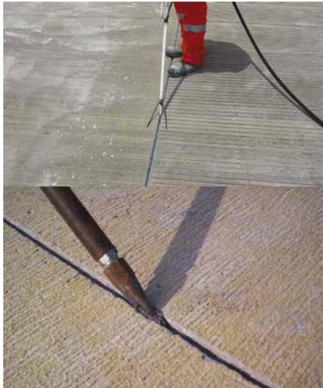
Los sellos de compresión preformados trabajan siempre a la compresión, con un intervalo que varía normalmente entre 20 % y 50 % del ancho original. Se colocan presionándolos dentro de la junta o caja, y pueden requerir de la aplicación de un material lubricante, que además actúa como mejorador de adherencia con las caras del aserrado.
