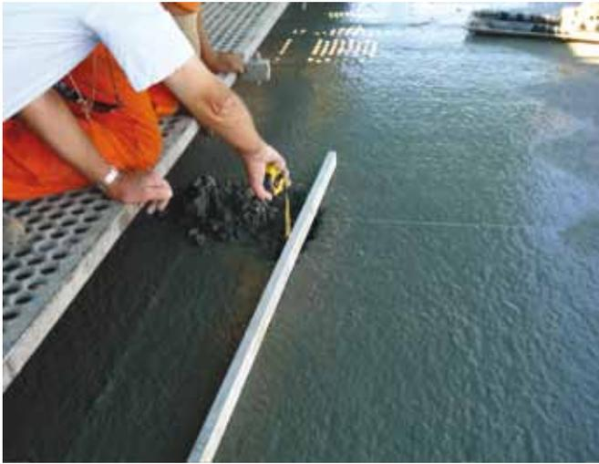
**Figura 12:** Control de profundidad de colocación del pasador.
