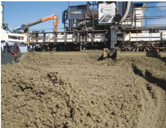
Figura 2: Distribución del hormigón con tornillo sinfín y pala distribuidora.
