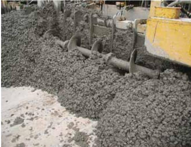
Figura 1. Distribución del hormigón con tornillo sinfín.
