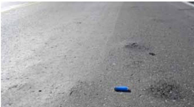
Fotografía N° 1. Caso N° 1, ampollas en superficie de pavimento asfáltico
