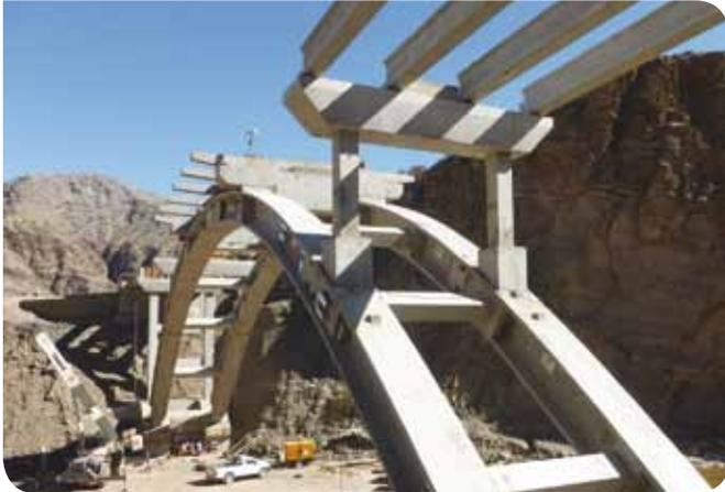
Figura 11: Puentes Arco en etapa de montaje.
