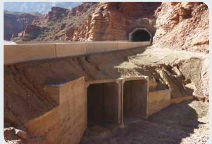
Figura 1: Defensas de hormigón, alcantarilla prefabricada y postesada y portal de entrada de uno de los túneles, minimizando el impacto ambiental en medio de un paisaje de cerros y quebradas.
