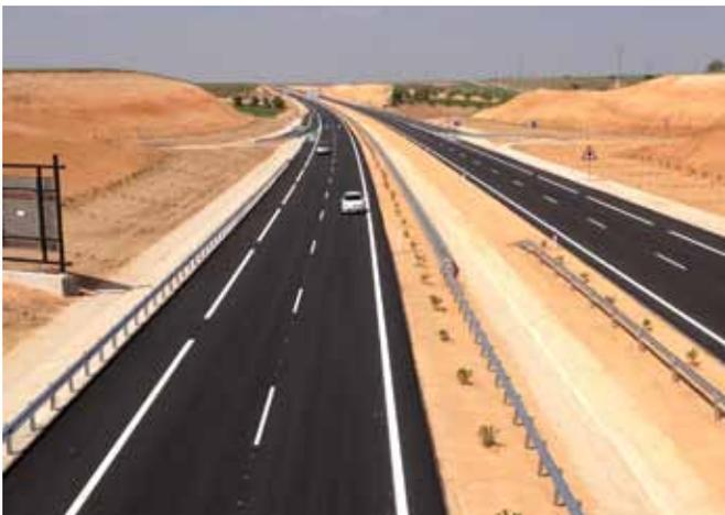
Foto 3. Colocar la barrera cerca del eje de la mediana aumenta las posibilidades de evitar un accidente, ya que el conductor que se sale de la vía tendrá posibilidades de rectificar su trayectoria antes de colisionar con la barrera.
