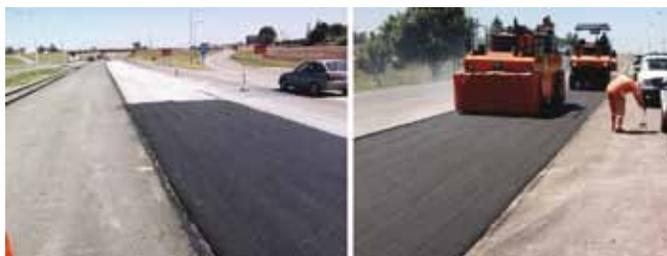
Figura 11. Colocación de capa de regularización
