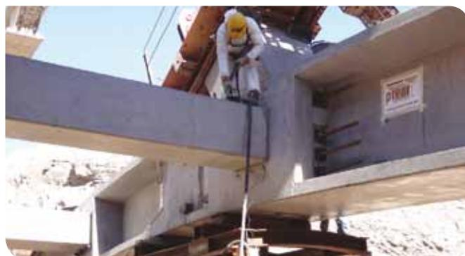
Figura 10: Rellenado de las vainas con inyección de grout cementicio.
