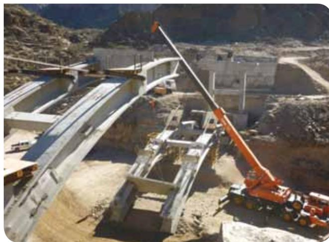
Figura 8: Puenete 5. Vista de los dos semiarcos armados con uno de ellos ya izado, en espera del otro.
