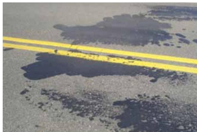
Fotografía N° 4. Manchas por exudación de mástico asfáltico
