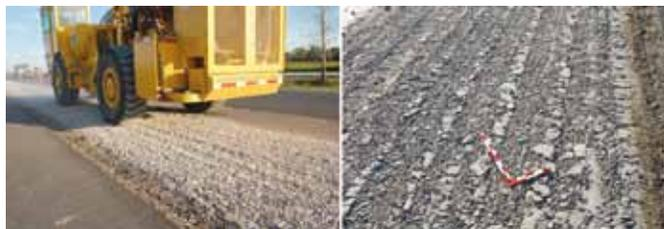
Figura 9. Vista de losa triturada
