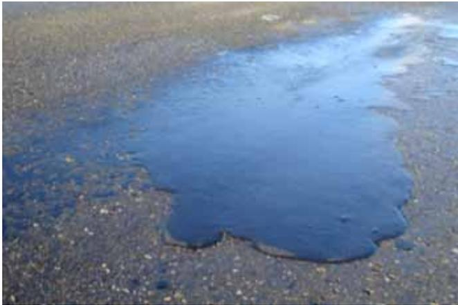
Fotografía N° 5. Detalle de sector con exudación
