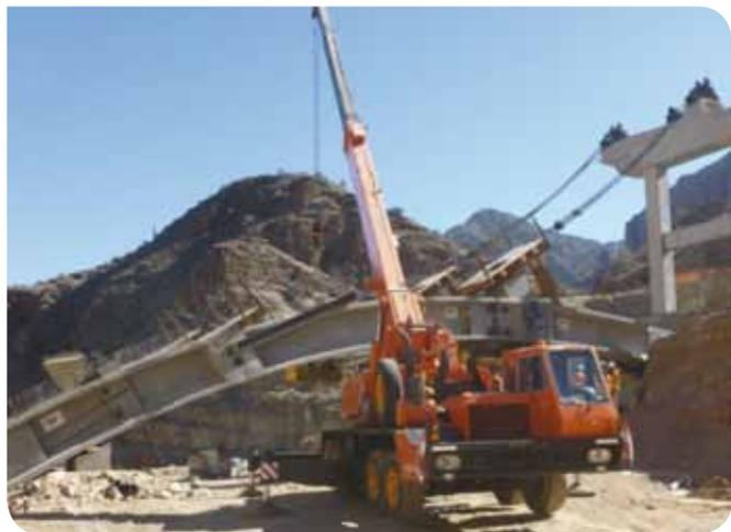
Figura 6: Puenete 5. Vista del semiarco ensamblado y listo para izaje.
