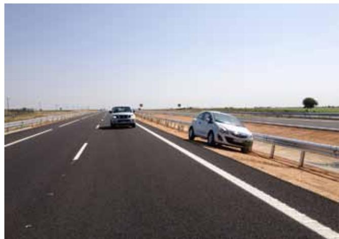
Foto 4. La reposición de la barrera y las tareas de conservación se realizan de una manera más segura cuando ésta se dispone próxima al eje de la mediana ya que se encuentra más separada del carril rápido, reduciendo el riesgo para los operarios.
