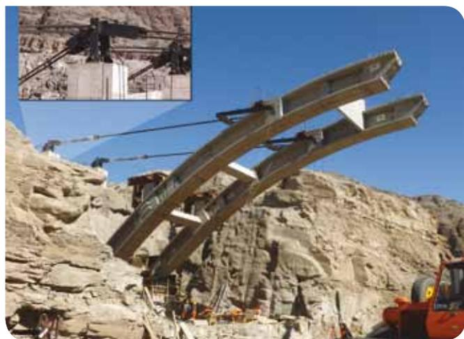
Figura 7: Sistema auxiliar de izaje.
