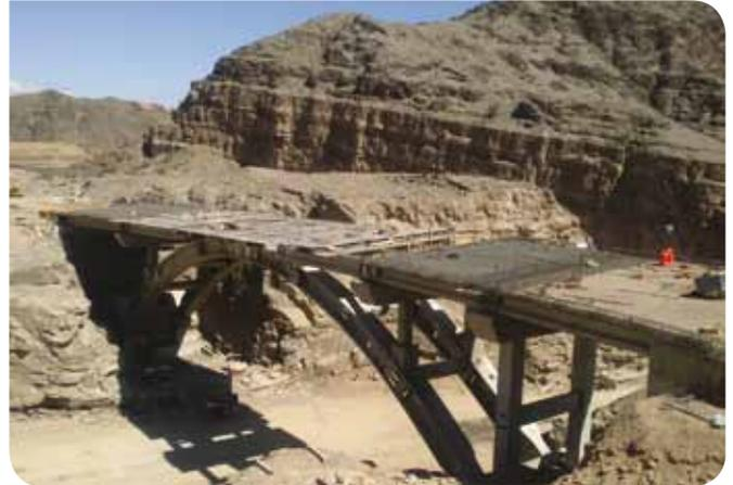
Figura 12: Ejecución de Tablero en Puentes Arco.
