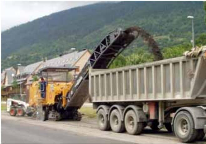
Foto 6: Fresado de firme envejecido para la obtención de RAP.
