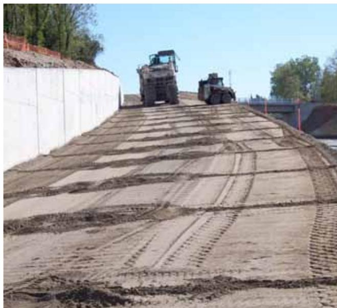
Foto 3: Ejecución de base de suelocemento con RCD.
