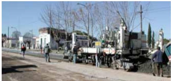
Foto 2. Ejecución con pavimentadora de encofrados deslizantes
