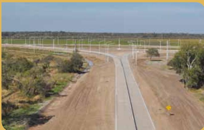
En el caso de los dos primeros tramos, el pavimento de hormigón se asentó sobre una base de suelo cal, mientras que en los dos últimos se ejecutó una base de Relleno de Densidad Controlada (RDC).
