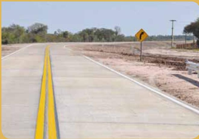
La obra comprendió la construcción de una calzada de hormigón simple de 7,30 m de ancho, cuyo eje corre paralelo al antiguo camino de tierra, con banquetas de suelo vegetal de 3 m de ancho y taludes con pendiente 1:4.
