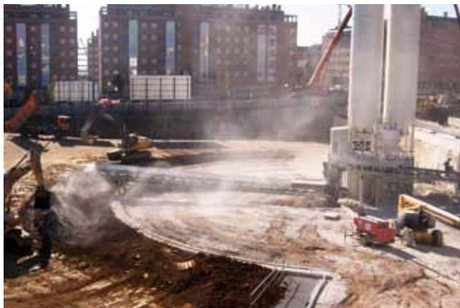
Foto 5: Tratamiento de lodos procedentes de la excavación de tuneladora.
