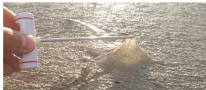
Fig. 9. Detalle de la formación de la membrana de curado en base a solvente.
