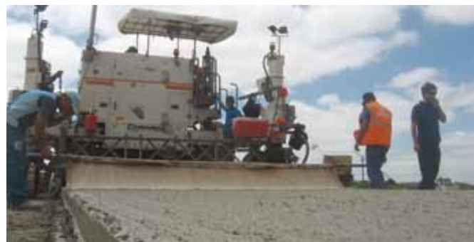
Fig. 8. Detalle de la superficie recién terminada y texturada con arpillera húmeda.
