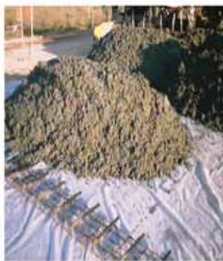
Figura 12: film de polietileno entre hormigón y subbase A4 estabilizada con cemento.
