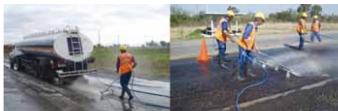
Fig. 4. Limpieza con hidrolavado (cisterna de 22 m 3 con dos bombas independientes).
