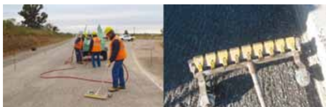
Fig. 5. Barrido con aire comprimido para liberar la superficie del polvo adherido.
