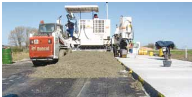
Fig. 7. Pavimentación de la segunda media calzada. Se coloca film en canto de juntas.
