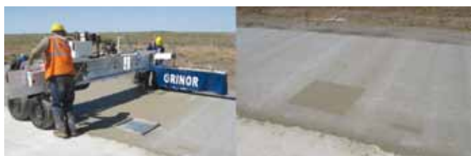
Fig. 10. Aplicación del compuesto líquido con carro de curado, y control de la dosis efectiva.
