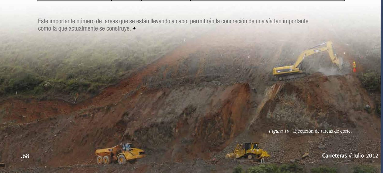
Figura 10. Ejecución de tareas de corte.
