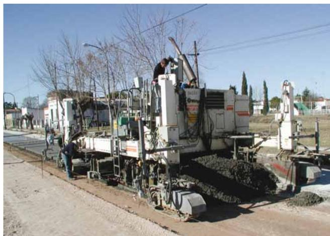
Foto 1. Ejecución de la calzada de hormigón en vía urbana con Tecnologías de Alto Rendimiento.
