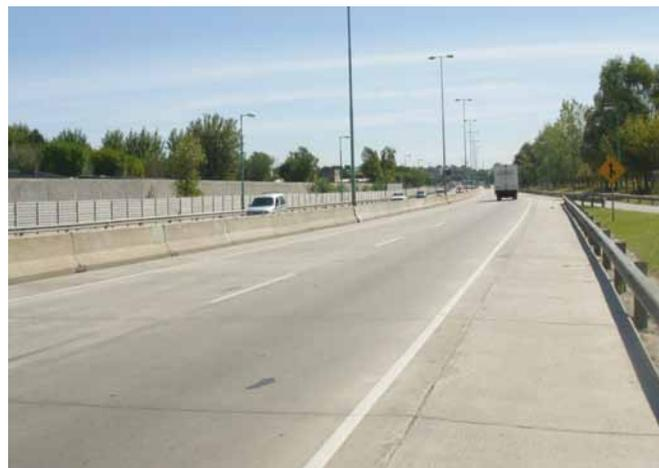
Foto 2. Calzada de hormigón con sobreancho en carril externo y banquetas de hormigón vinculadas
