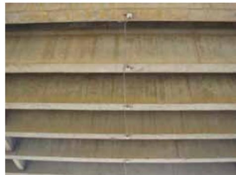
Foto 5. Sensores extensométricos SiWIM instalados en cada viga del puente
