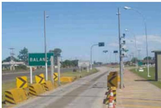
Foto 2. Vista de Sistema WIM de baja velocidad (10Km/h) con sensor de Celda de Carga y Torre de Cámaras, para derivación a playa de regularización de carga y penalización o reingreso a la vía principal
