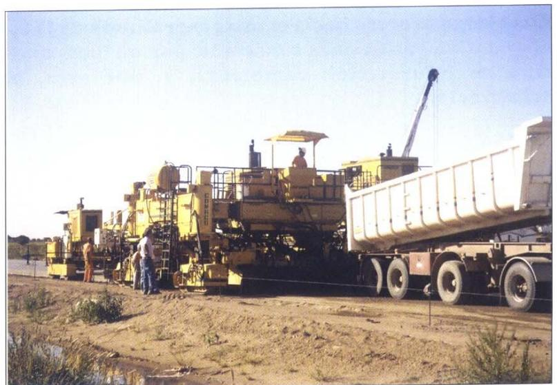
Se han adoptado sobreeanchos en la subbase de suelo cemento para proveer un carril de desplazamiento a las orugas de la pavimentadora
