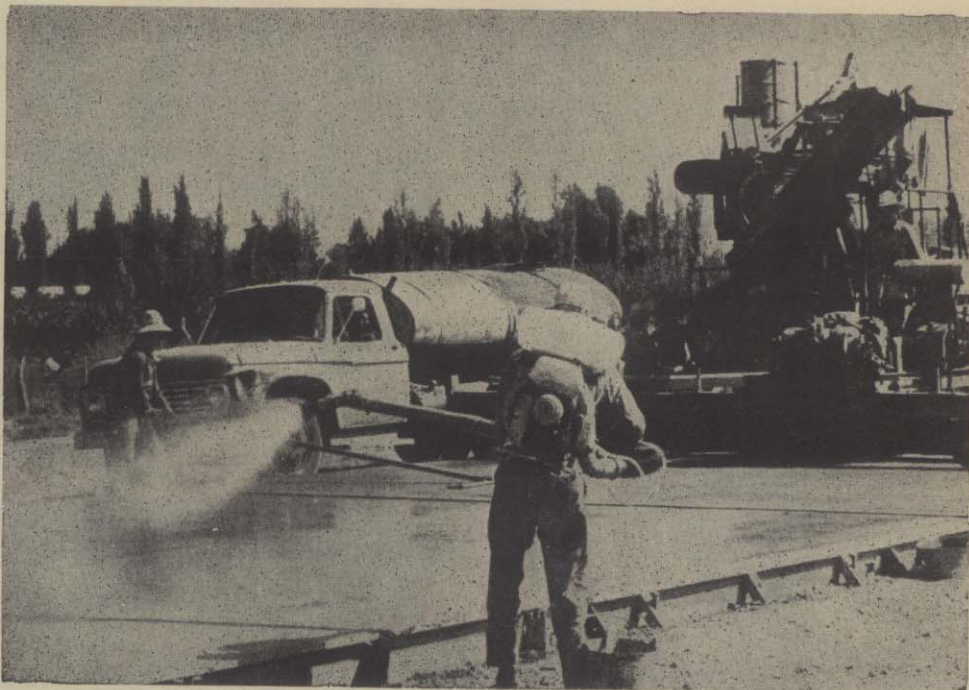
Ruta 40. Acceso Norte a Mendoza. El curado del hormigón de esta obra se efectuó con Antisol.
