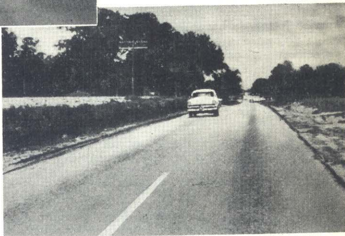
Primer camino de suelo-cemento construido en 1935 en Johnsonville, EE. UU., continúa sirviendo un tránsito pesado creciente.
