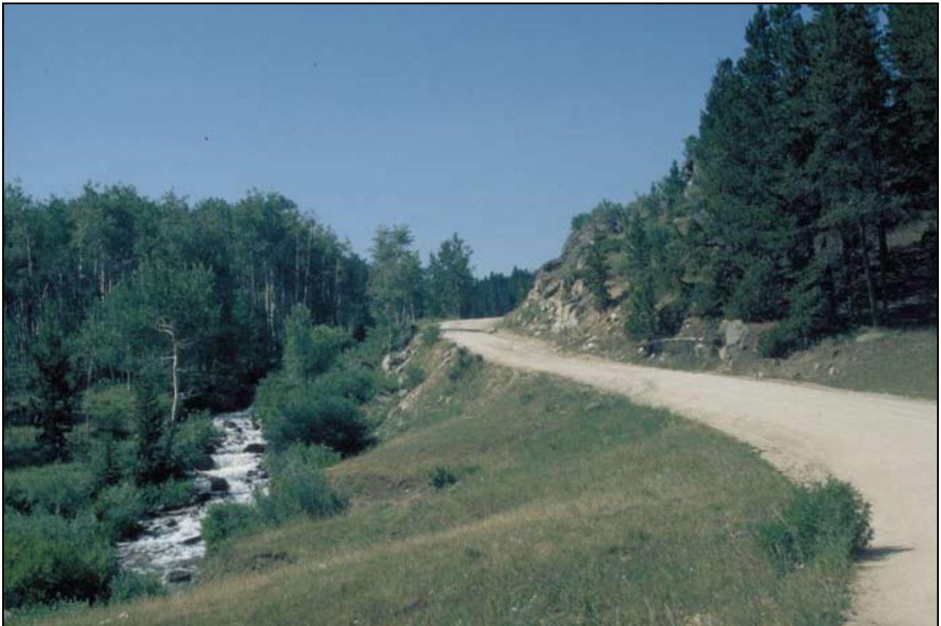
Foto 3.9 Ubicar los caminos y senderos de arrastre furera de los ríos y lagos. Este camino está demasiado cerca del río. Los sedimentos producidos en el camino llegarán al río.
