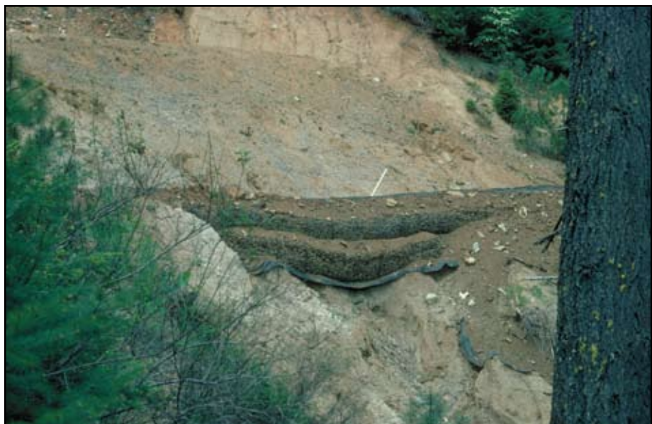
Foto 11.12 Una estructura de gaviones que fallará pronto debido a la falta de una cimentación adecuada. Todas las estructuras de retención, ya sean MSE o muros de gravedad, requieren una buena cimentación.
