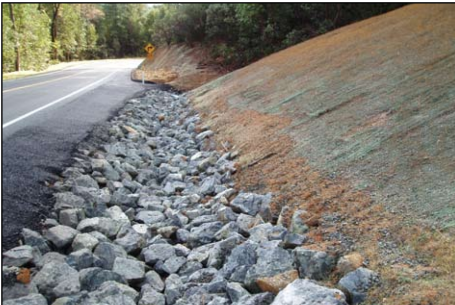
Foto 13.5 Cuneta a un lado del camino, revestida con rocas bien graduadas para el control de la erosión.
