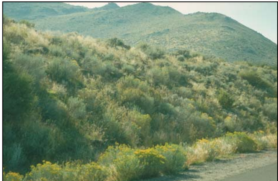
Foto 11.3 Talud de corte perfectamente estable, con una pendiente aproximada de 1:1 y bien protegido con vegetación.
