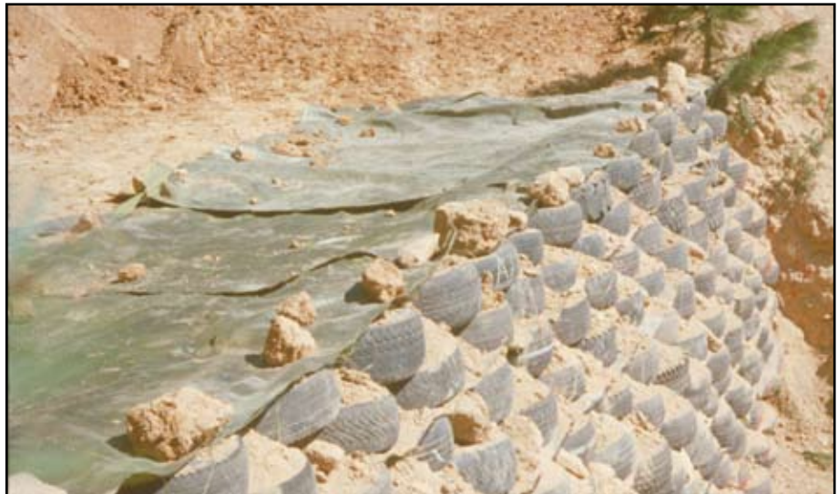
Foto 11.11 Muro de contención de tierra estabilizada mecánicamente (MSE), como Tierra Armada con la fachada protegida con llantas y con capas de refuerzo de geotextiles. Se usa para ampliar el camino en una zona con fallas en el terreno. Las estructuras tipo MSE son a menudo las estructuras de contención menos costosas disponibles. También se usan a menudo muros de malla de alambre soldado.
