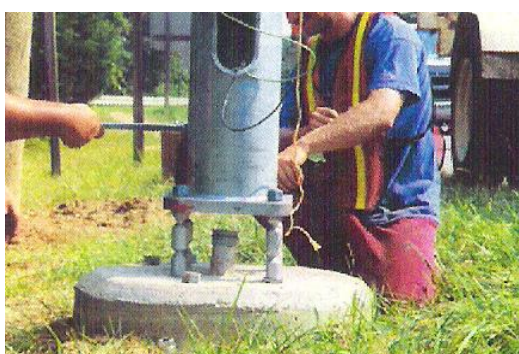
Postes frangibles con incorporación de fusibles en el basamento
