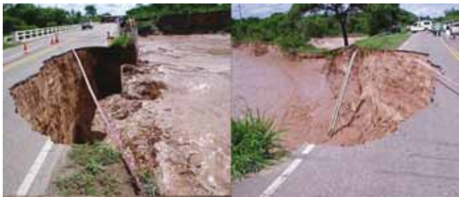
Inicio del proceso erosivo de socavación sobre la margen izquierda, por pérdida del terraplén de aproximación
