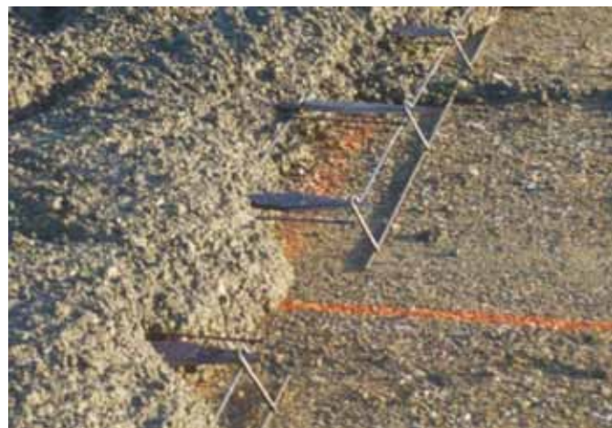
Figura 7b: Canasto de pasadores placa romboidal.
