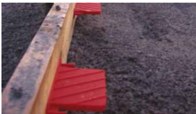
Figura 6b: Inserto prefabricado cuadrado para pasador placa rectangular, instalado sobre un molde de madera, en junta de construcción.
