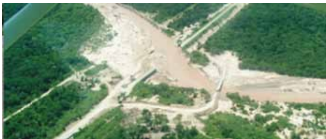
Inicio del proceso erosivo de socavación sobre la margen izquierda, por pérdida del terraplén de aproximación
