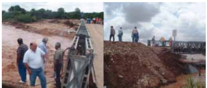
Imágenes del puente provisorio colocado aguas abajo del principal, para el cruce temporal
