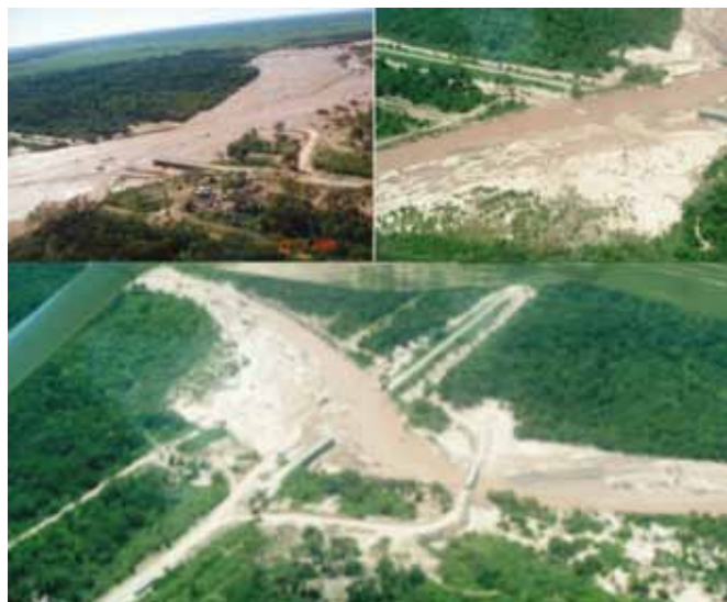
Imágenes de puente erosionado. Obsérvese la gran superficie erosionada, y especialmente la zona de margen izquierda, aguas arriba del puente.
