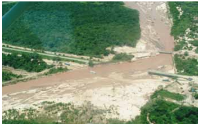
Se observa aguas abajo la implantación de un Puente Bailey para el cruce del río en una sección más estrecha. (En el siguiente pico de crecida, desapareció el Bailey.)
