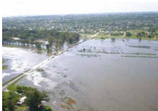
Junín – Ruta que atraviesa planicie de inundación sobrepasada por creciente.
