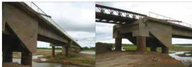
Erosión en la base del estribo
