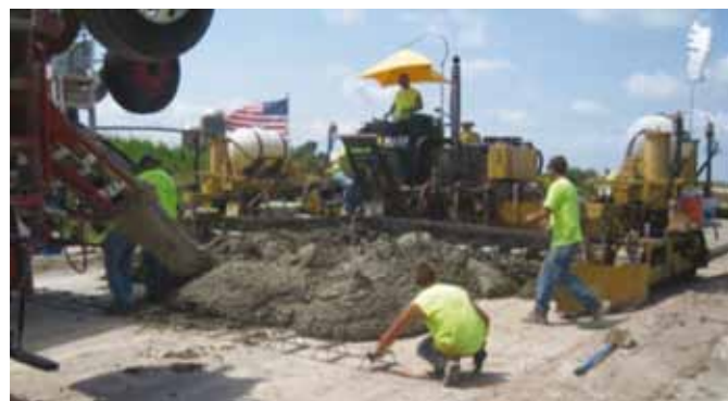
Figura 8: Construcción de un pavimento industrial con equipo de encofrado deslizante que incluye canastos con pasadores placa trapecoidal. Se observa que el pavimento era de 20 cm de espesor y que los canastos eran fijados en el frente de las operaciones de la pavimentadora de encofrado deslizante previo a la descarga del hormigón, permitiendo que la subrasante preparada sea utilizada para el transporte del mismo.
