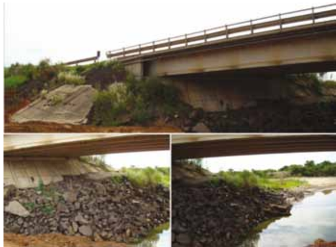
Erosión en la base del estribo
