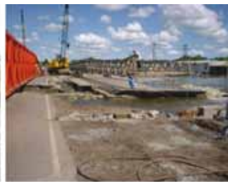
Puente sobre RN7
