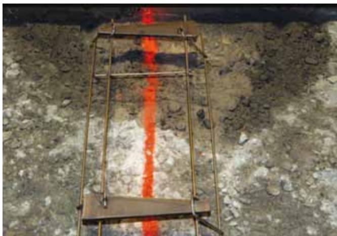
Figura 7a: Canasto de pasadores placa tipo trapecoidal, colocadas en forma alternada.
