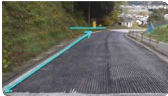
Sección de prueba en Japón, con el objetivo de mejorar el comportamiento ante el hielo.
