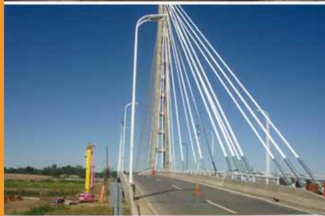
Los anclajes de los tirantes se sitúan en los bordes extremos de la vereda y bicisenda.
