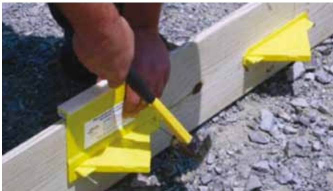
Figura 6a: Instalación de un inserto prefabricado para pasador placa diamante sobre un encofrado de madera, en una junta de construcción.
