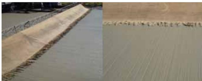
Figura 09. Texturizado con arpillera húmeda en Sección A
