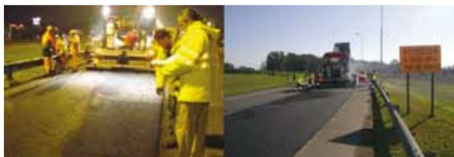
Figuras 6 y 7: Extendido de PmB-WAM en ambas secciones con menor emisión
