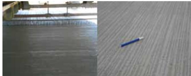
Figura 10. Texturizado con arpillera + peine transversal en Sección B
