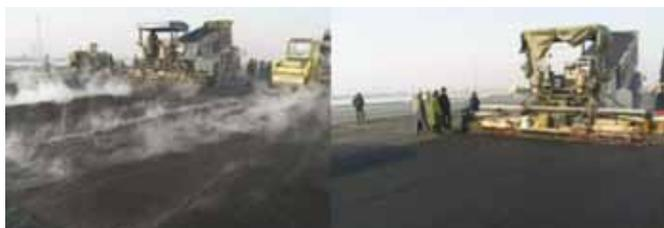
Figuras 1 y 2: Comparación de emisiones durante la utilización de PmB HMA y WMA
