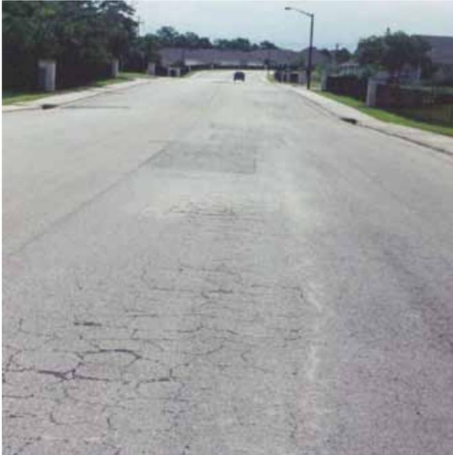
a) Tramo Base Flexible. La humedad entra a menudo al material de la base vía filtración por junta de construcción. La falta de un sellado efectivo sobre la base puede acelerar el deterioro. El riego por aspersión es otro problema.
