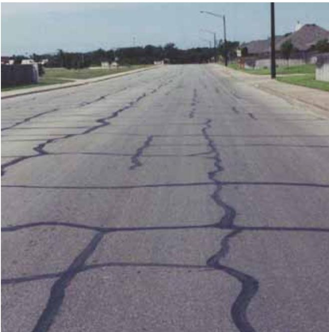
b) Tramo Suelo-Cemento. Excesiva contracción de la base estabilizada produce fisuras en bloque. Al principio es cosmético pero puede conducir a problemas estructurales y pérdida de la calidad de rodamiento.
