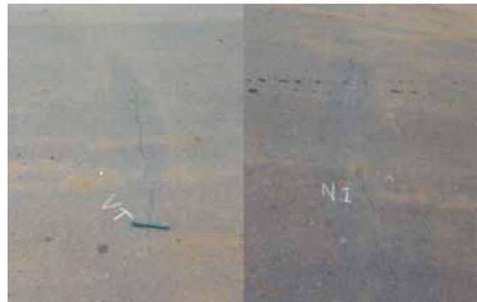
a) Von Trapp (2 fisuras en tramo) b) Neuburg (única fisura en tramo de 455 pies -139 m-).
