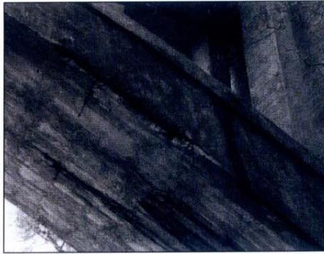
Foto 16. Vista de un puente arco de hormigón con daños debidos a corrosión de los cuchillos de autocimbra.
