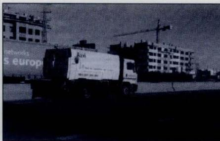
Foto 3. Barrido del arcén de una carretera, con eliminación de los residuos superficiales.
