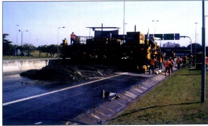
Foto N°4: Colocación del Recubrimiento de Hormigón. Autopista AU7. Ciudad Autónoma de Buenos Aires
