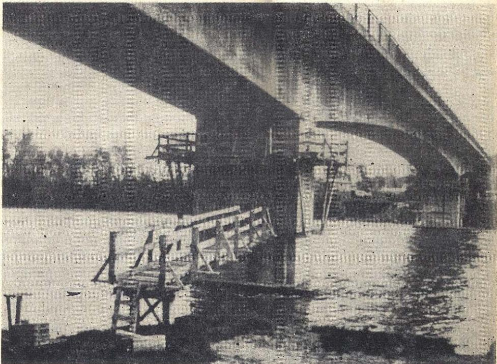
Acceso a un cabezal de pila para trabajos de reparación. Se observará lo pesado de tales medios, difíciles de considerar para un reconocimiento de rutina.
